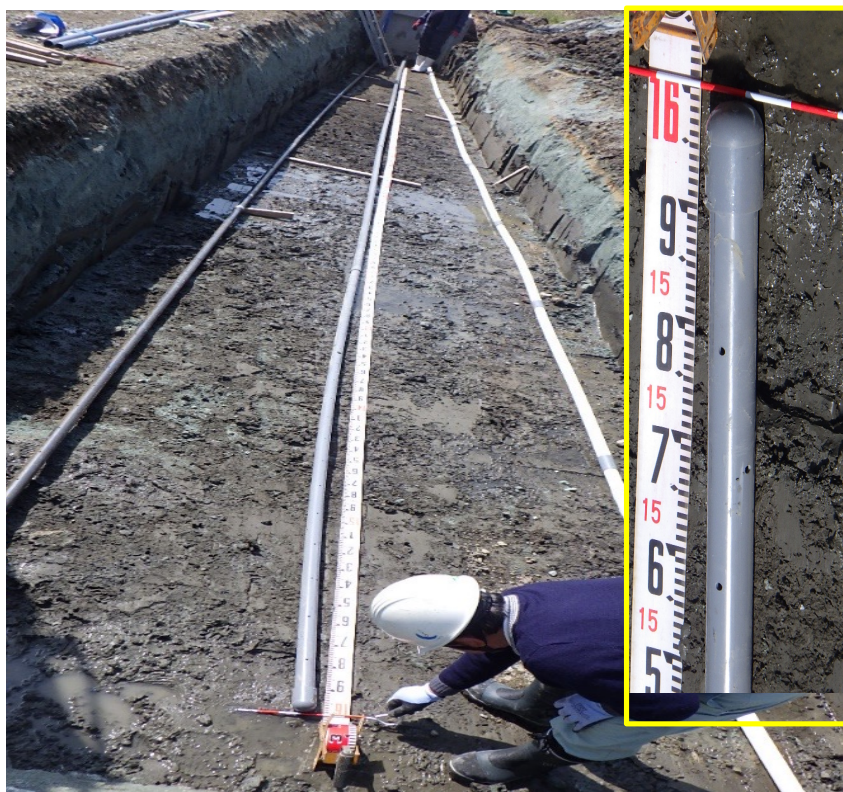
集水桝から16m敷設
