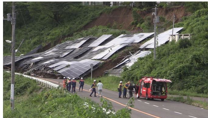
太陽光パネル
