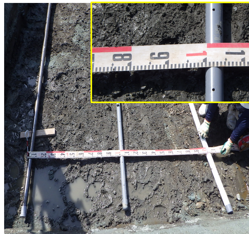
パイプ設置は集水桝から放射状 間隔1m
